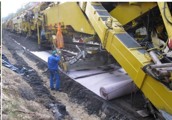
Bild 1b: Gleisgebundener Einbau des Vliesstoffes.
